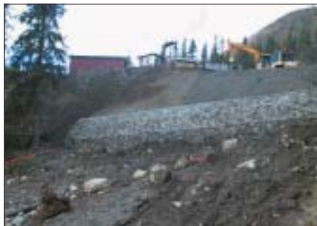
Mur følger helning på terrenget
