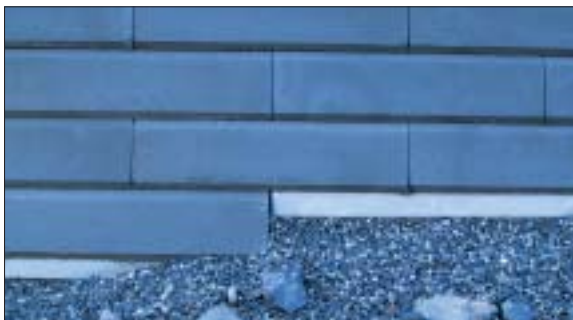
Blokkene legges normalt i forband
