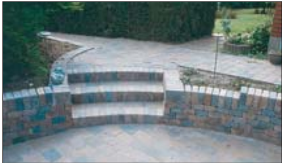
Pyntemur av belegningsstein
