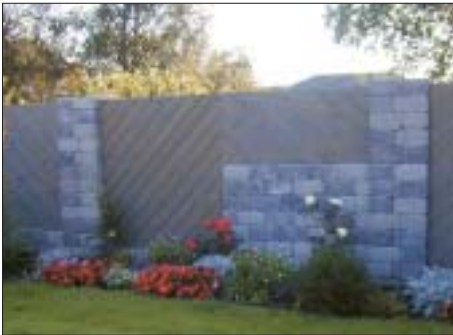
Pyntemur av tromla betongblokker, kubber
