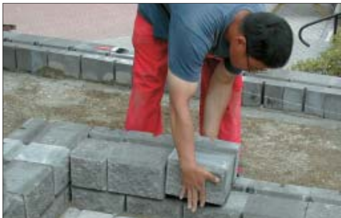
Manuell legging av betongblokker
